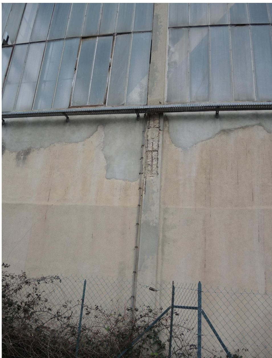
Hangar VI photo vue d'une façade extérieure
