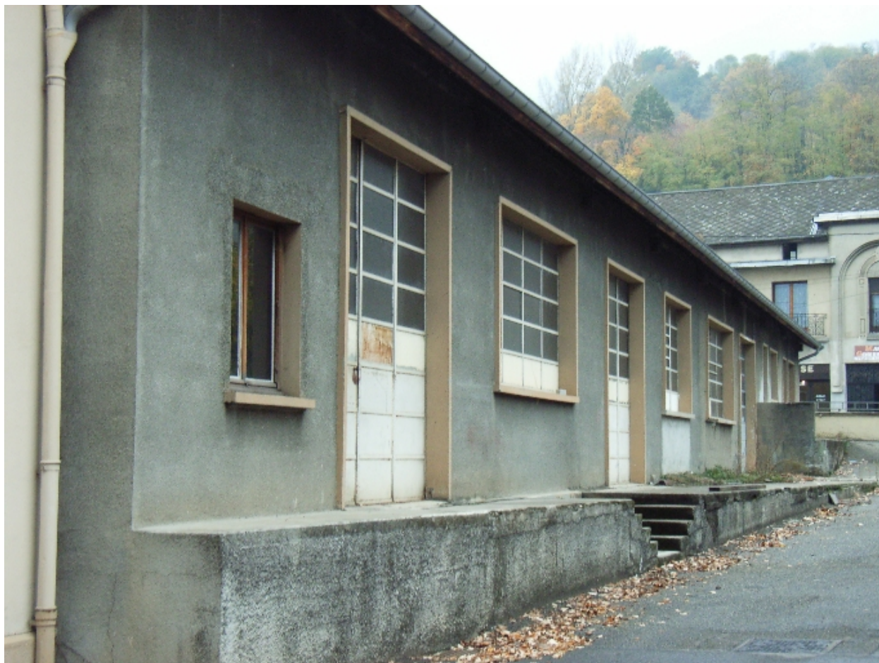
Bâtiment avec quai de déchargement, première cour
