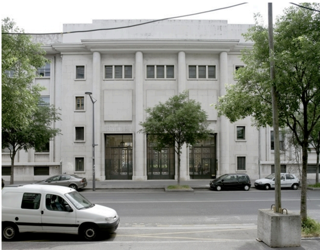
Entrée principale, série de trois portes en ferronnerie et verre (Piguet métallier)
