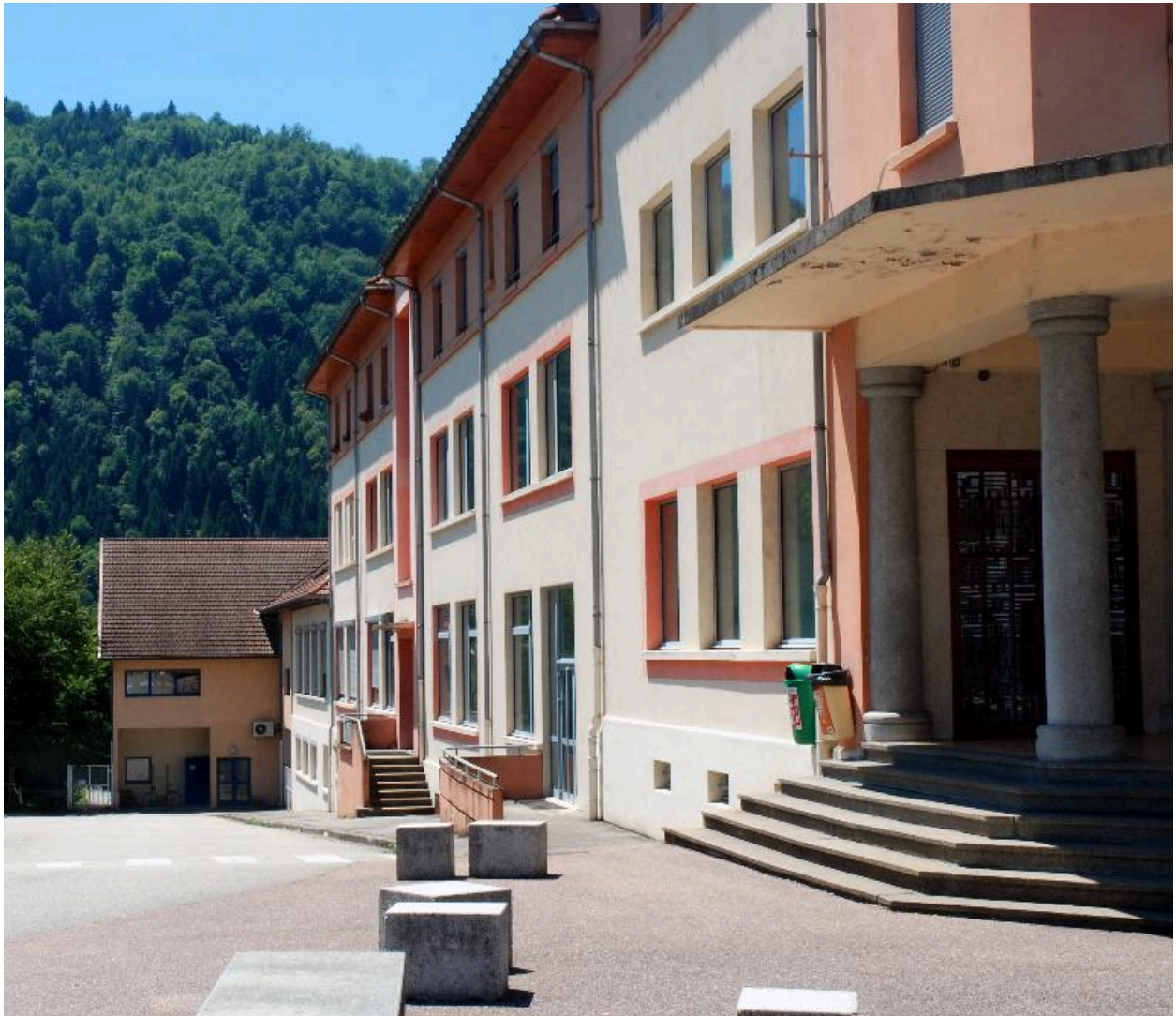
Elévation latérale est, depuis le nord
