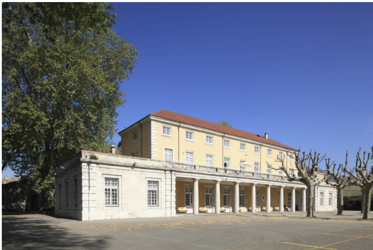
Bâtiment C. Façade sud. Espace de l'administration.
