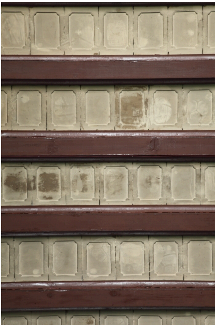
Gymnase. Plafond, détail.
