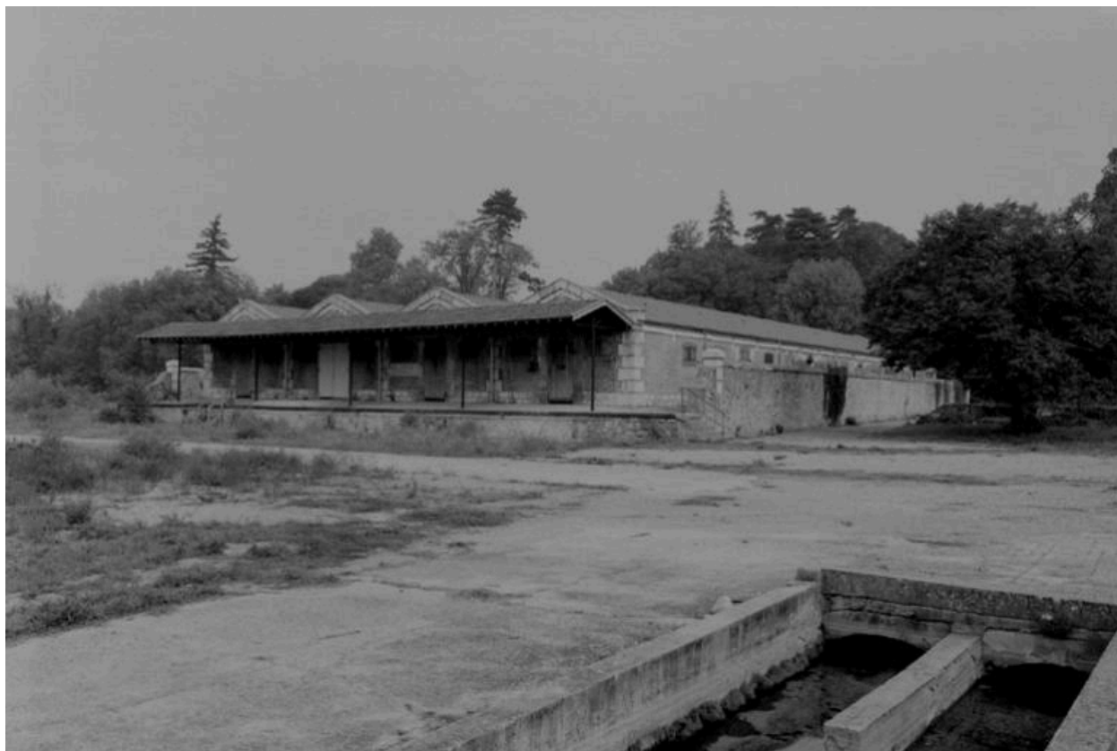
La gare, vue sud
