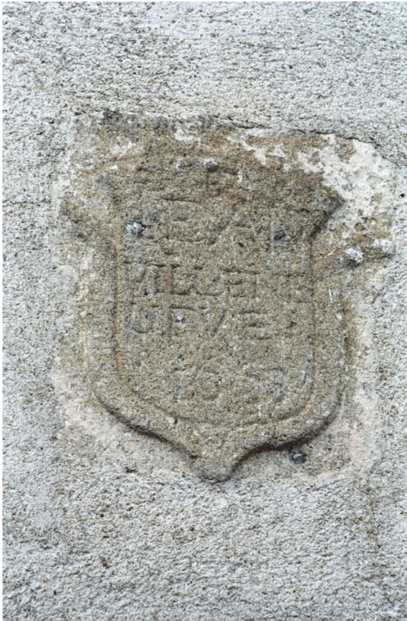
Presbytère, détail des armoiries sur la façade sur rue.
