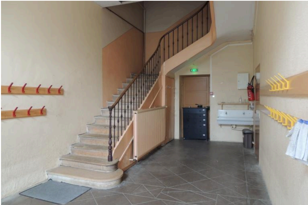
Escalier du bâtiment principal.
