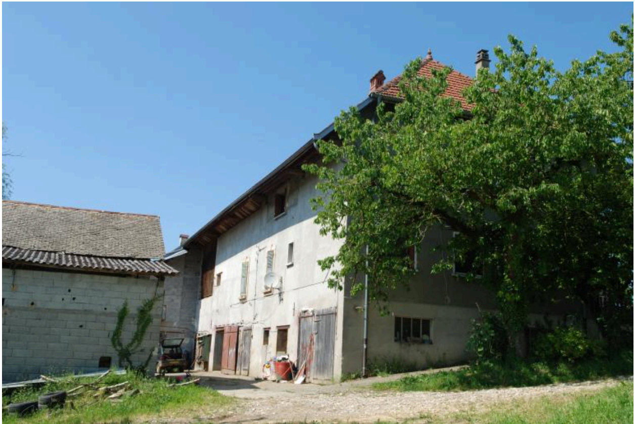
Vue d'ensemble côté étage de soubassement.
