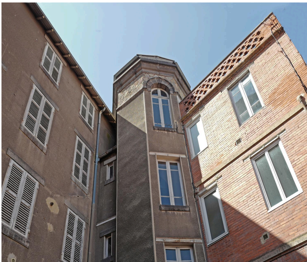
Elévations postérieures sur la cour
