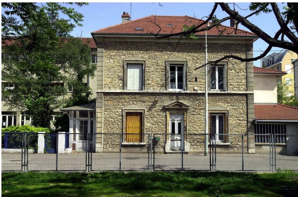
Elévation antérieure de la maison
