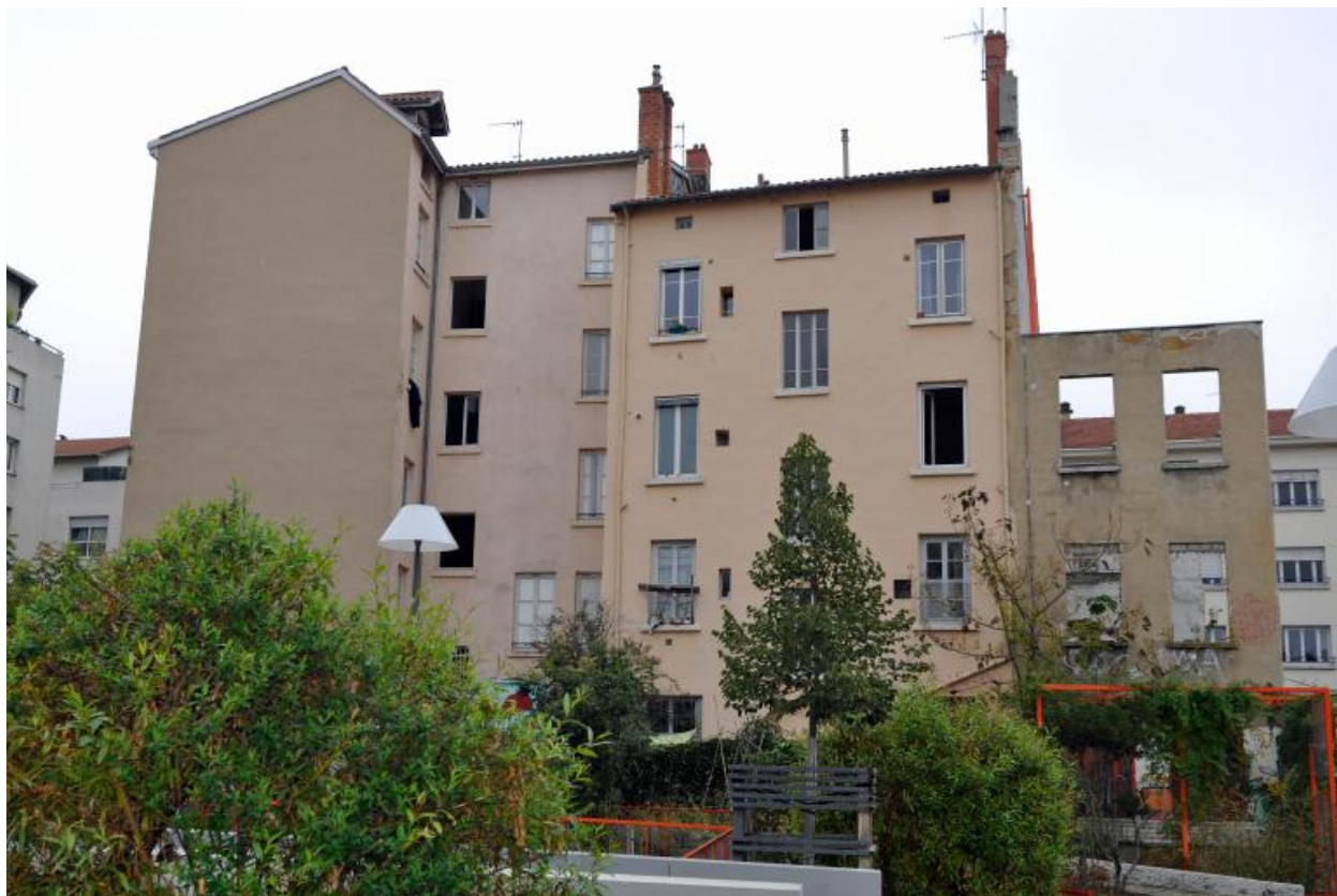
Vue de situation depuis le sud, élévation postérieure
