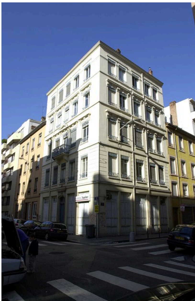
Vue générale de l'immeuble
