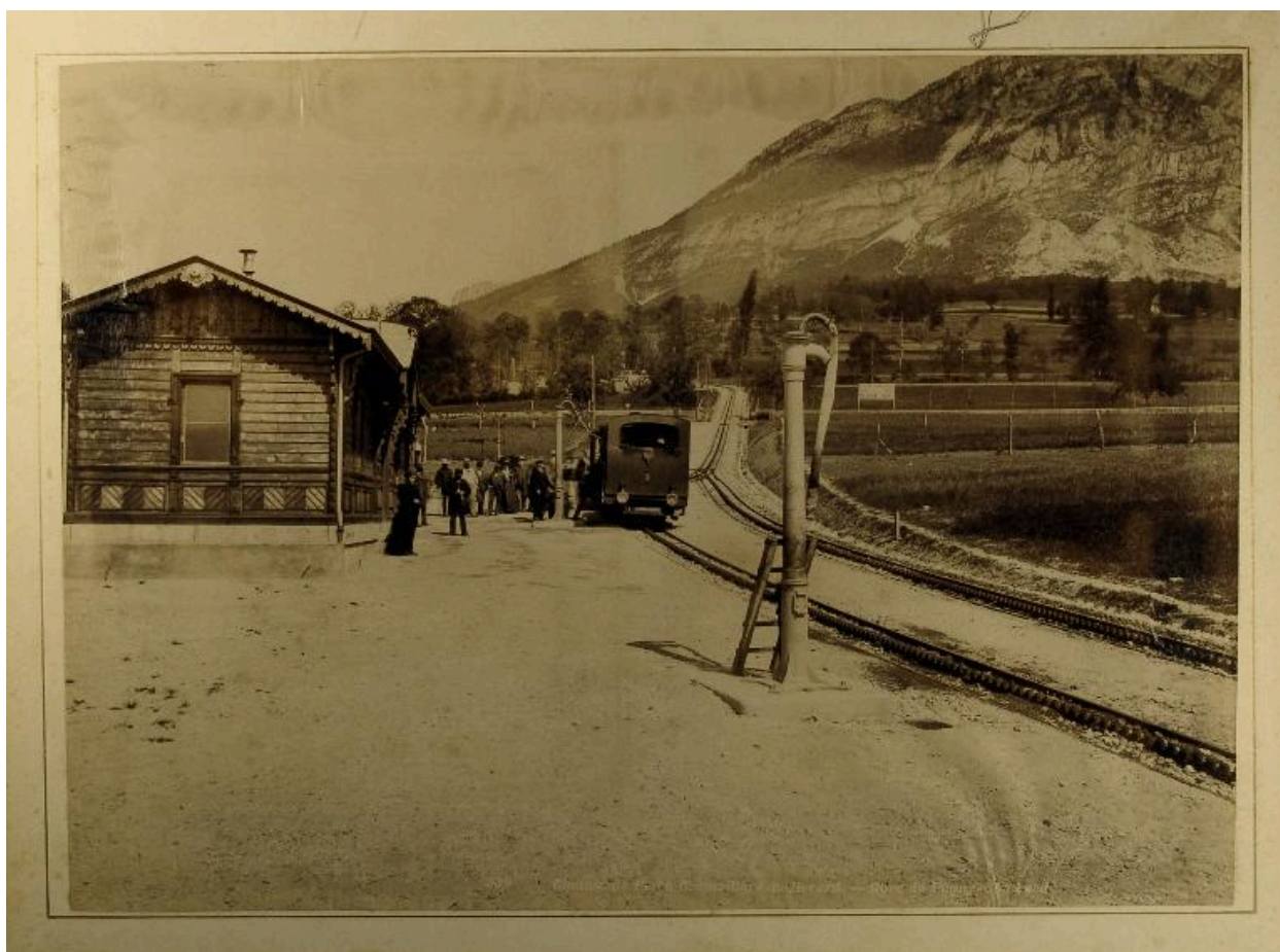
Station du chemin de fer à crémaillère qui dessert les Corbières, 1895
