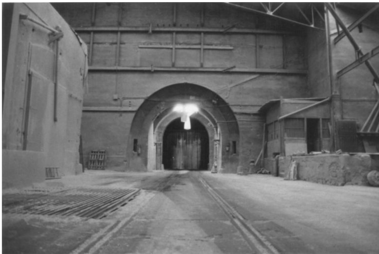
Vue intérieure, partie supérieure du mur formée d'une verrière rampante
