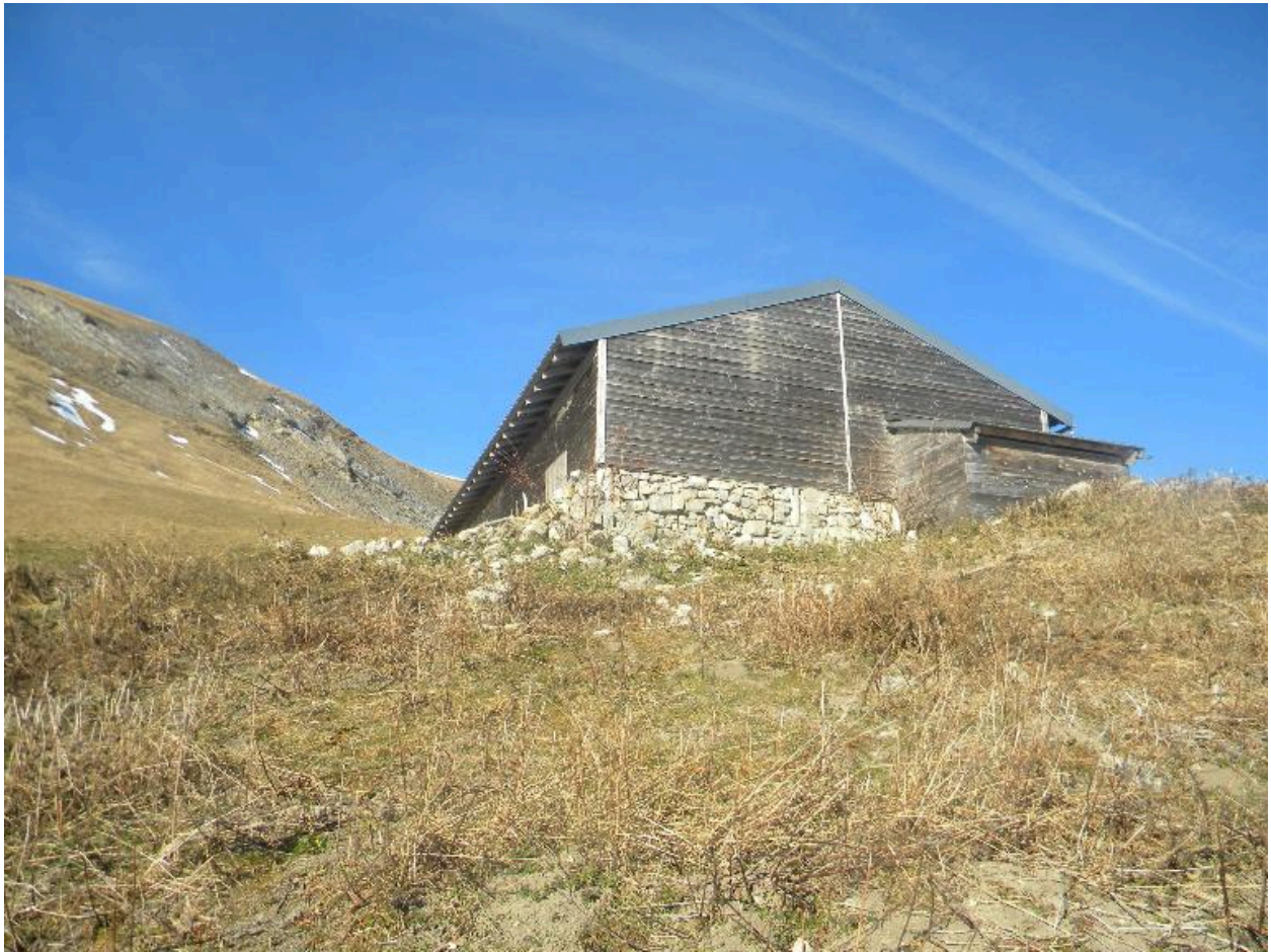
Vue du pignon est de l'étable.
