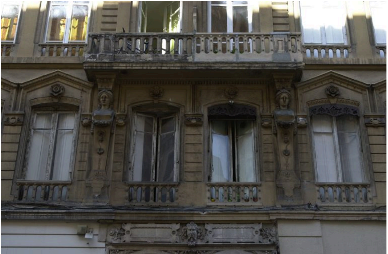
Elévation antérieure, premier étage carré : les travées centrales
