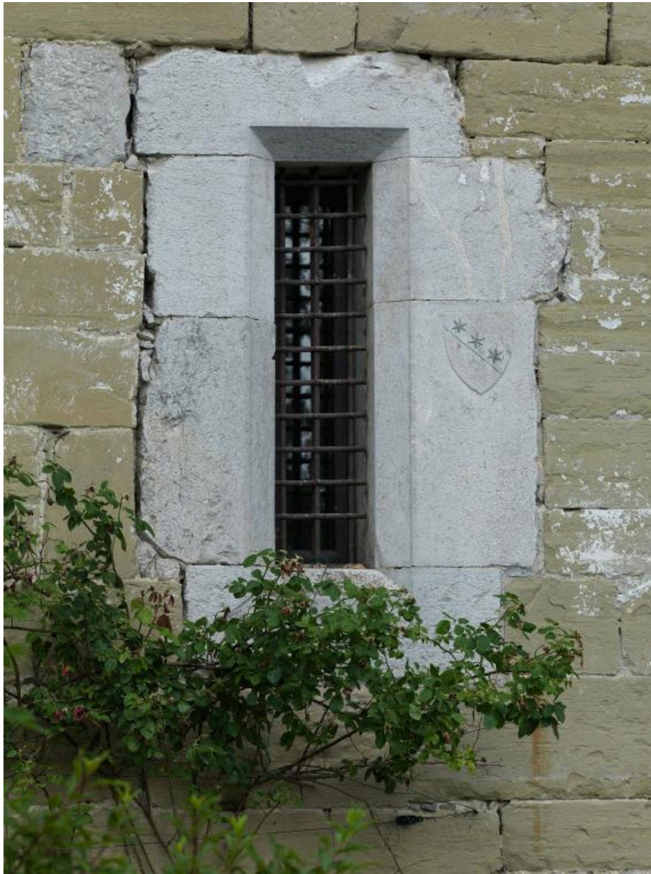
Détail d'une baie en calcaire de l'escalier en vis, façade est.
