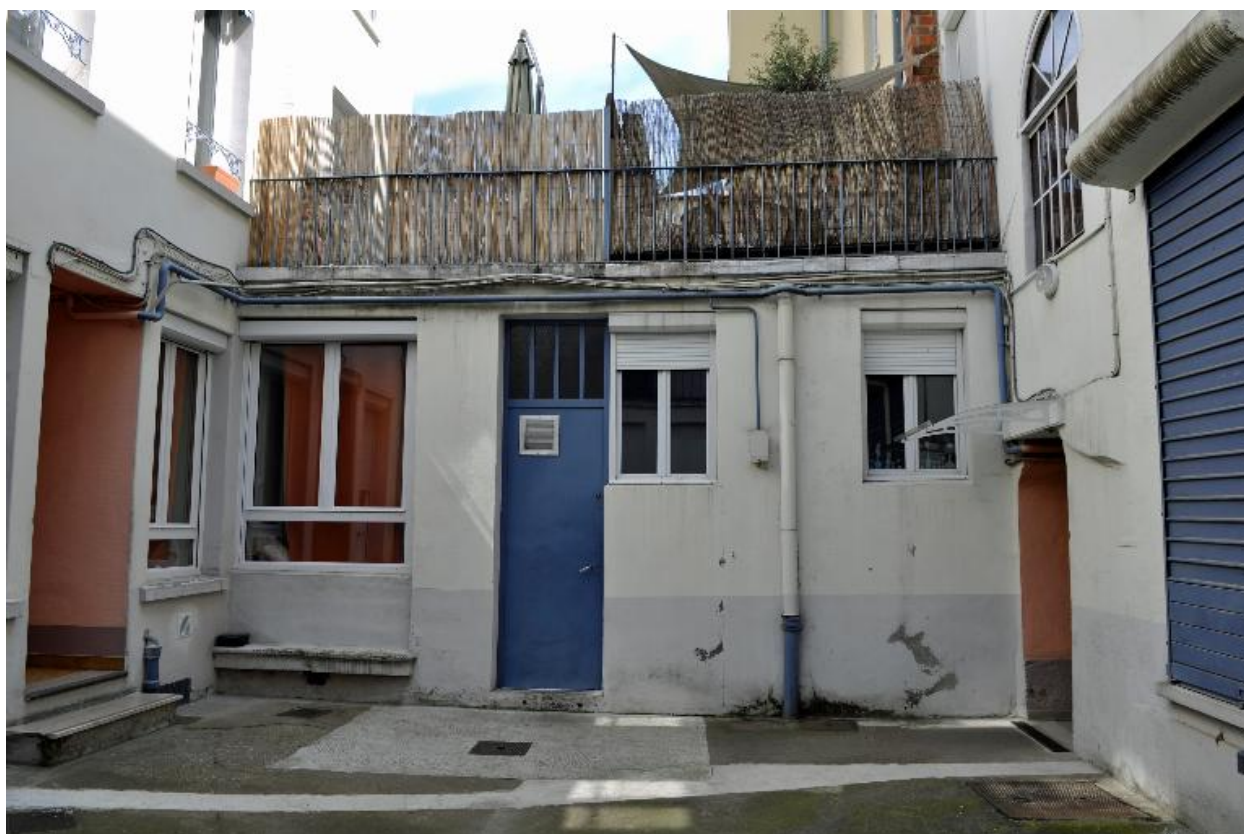
Dépendance sur cour formant terrasse, côté nord
