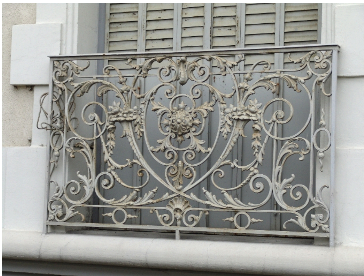
Détail d'un garde-corps
