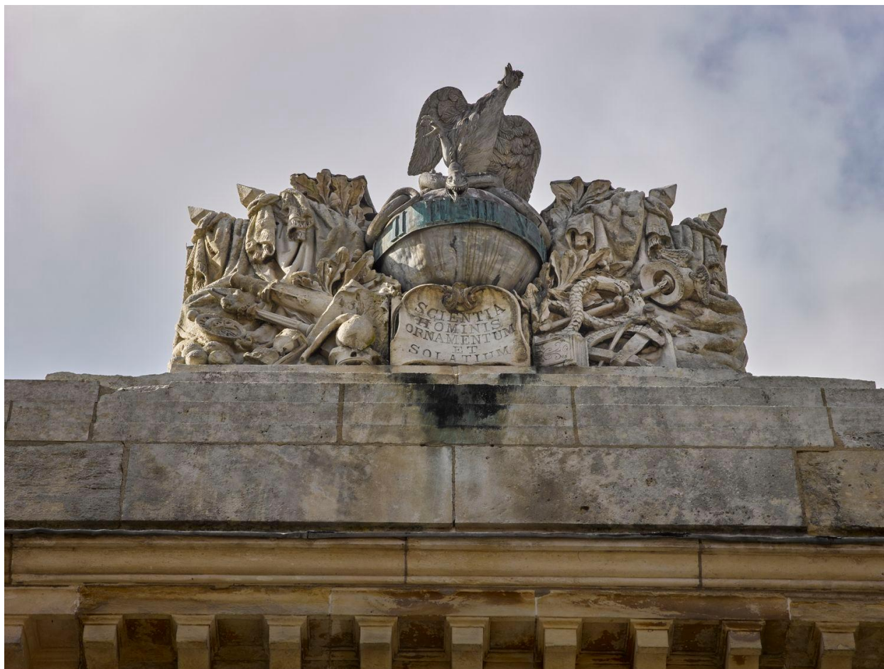
Porche : détail de l'amortissement.
