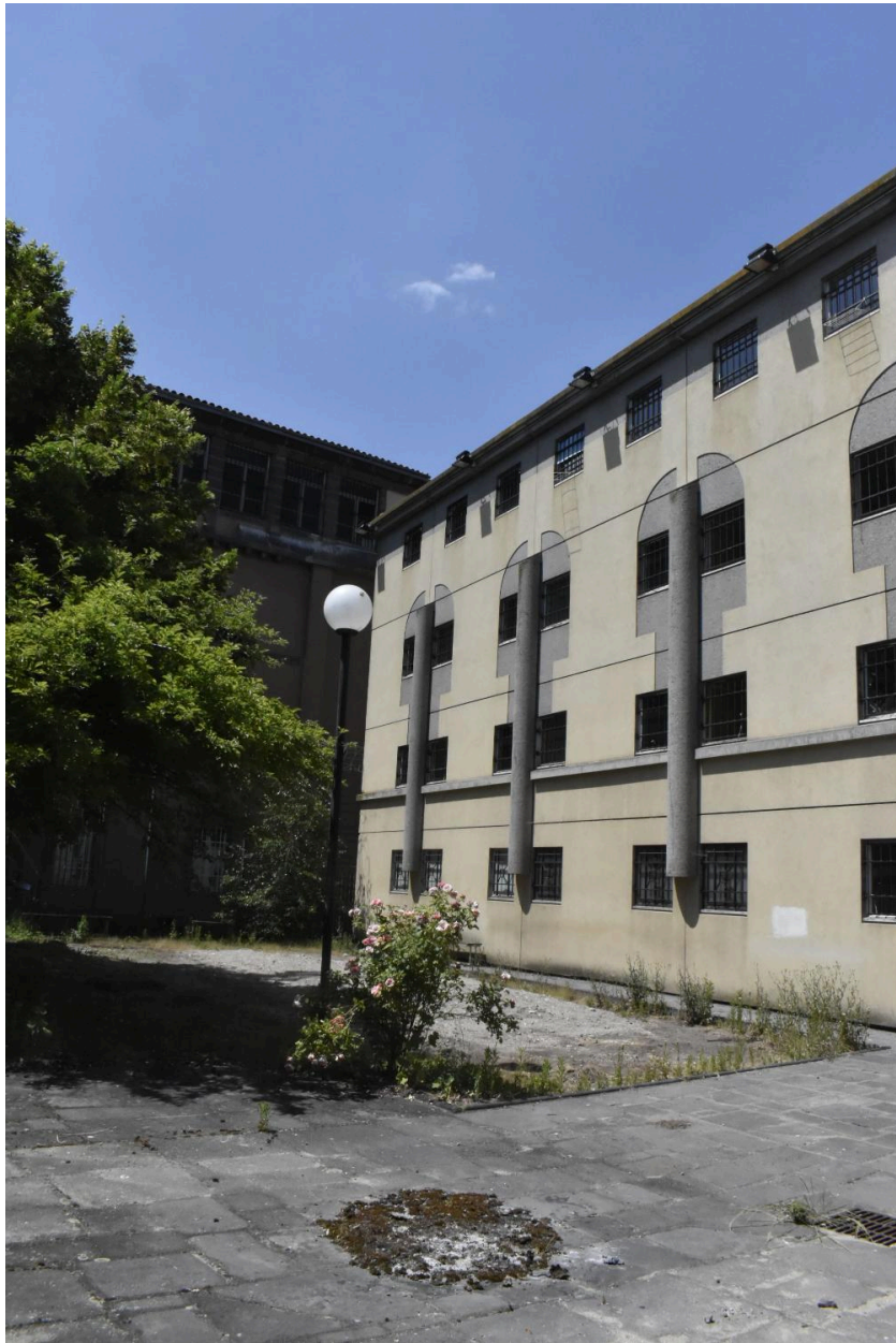
Angle nord-ouest de la cour est.
