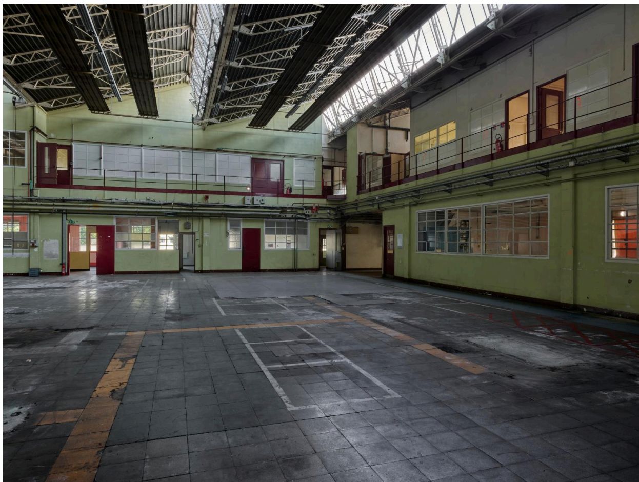
Intérieur de l'atelier F14, désaffecté.
