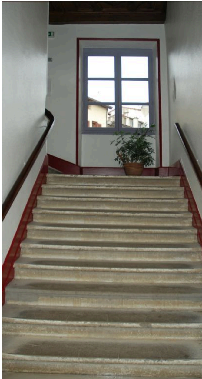
Grand-escalier rampe-sur-rampe, volée conduisant à l'étage, 17e siècle.
