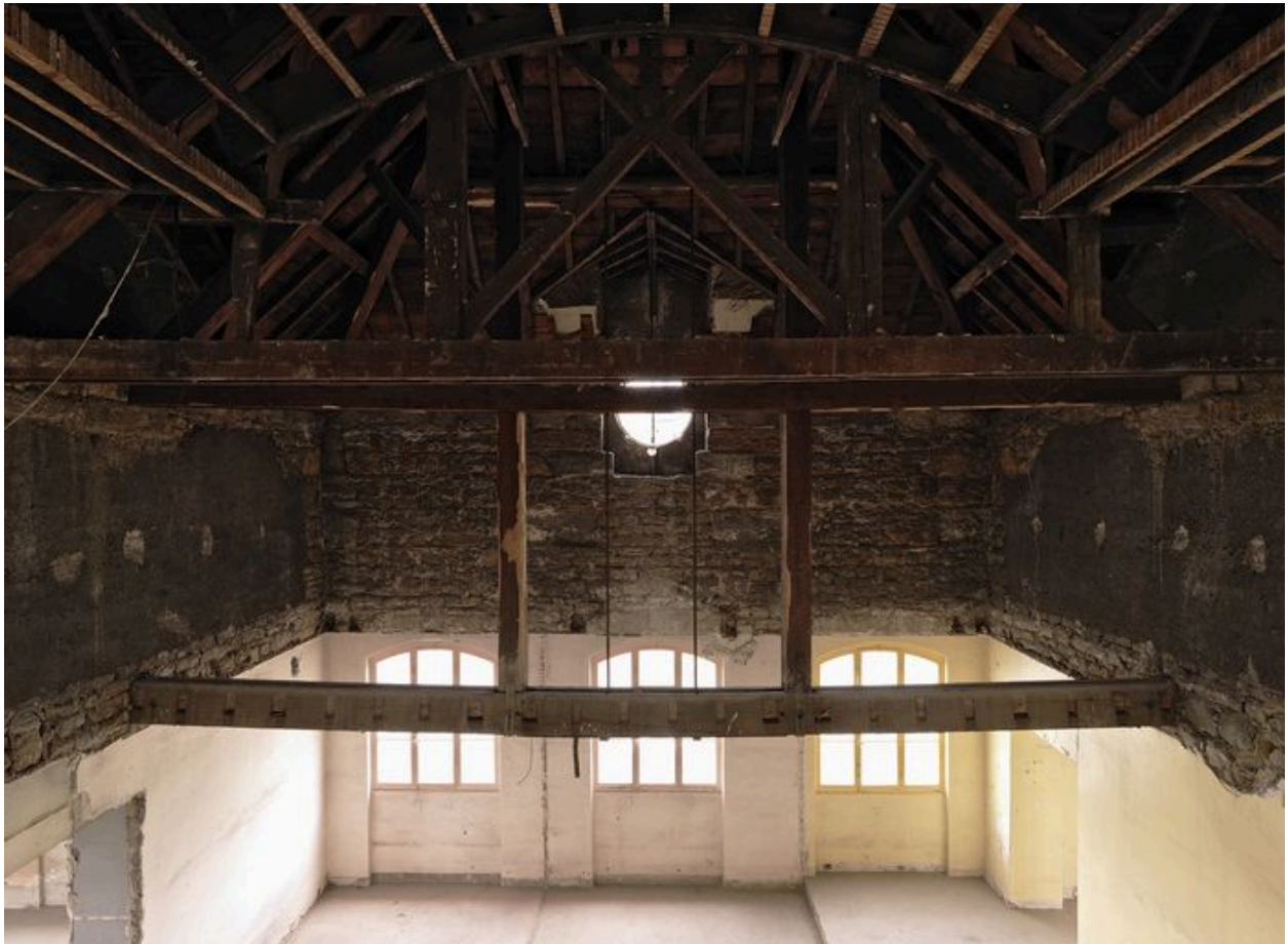
Vue de la charpente au-dessus de l'escalier d'honneur en mai 2011.
