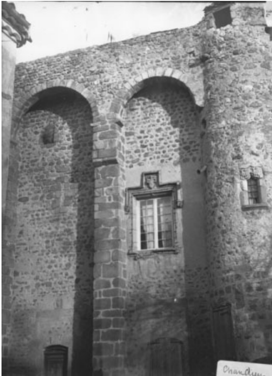
[Vue de l'extrémité sud de la façade occidentale de l'aile ouest.] Photographie argentique sur plaque de verre, limite 19e siècle 20e siècle ; tirage moderne scanné. Coll. Part. Thiollier-Sénéclauze. 41-34
