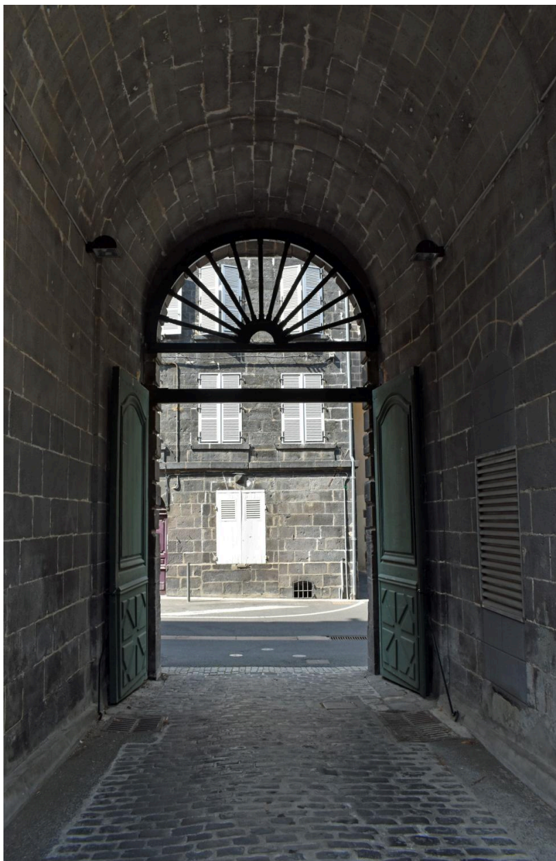
Bâtiment C : passage de l'entrée principale, depuis la cour
