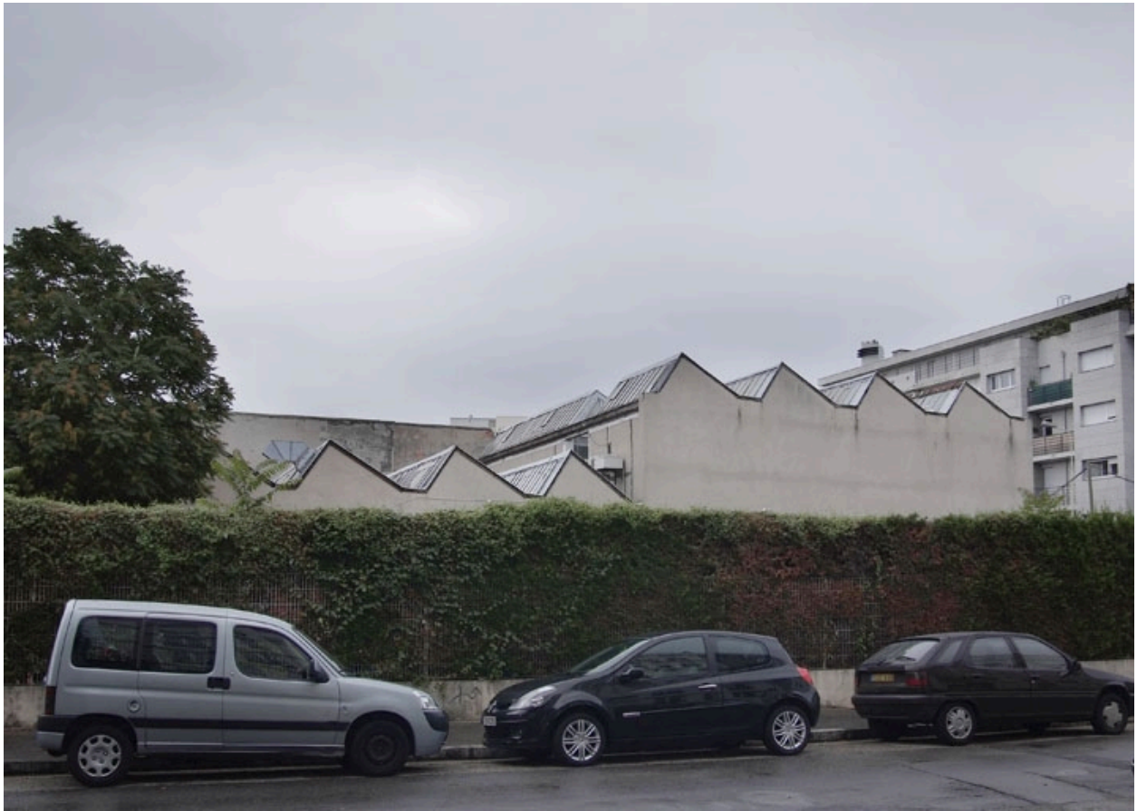
Vue ouest des ateliers
