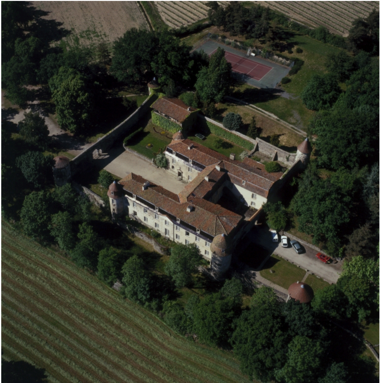
Vue aérienne, du nord.
