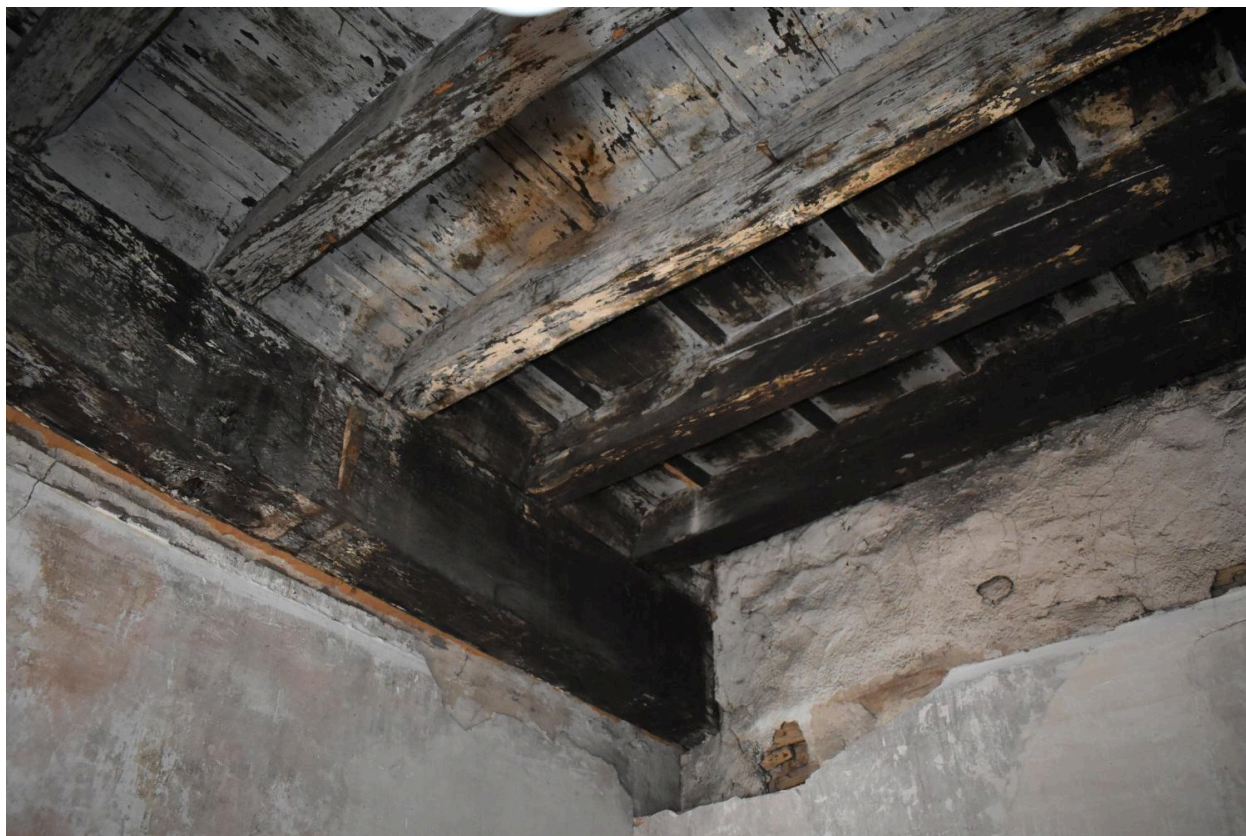
Etage carré, détail du plafond de la chambre 1.
