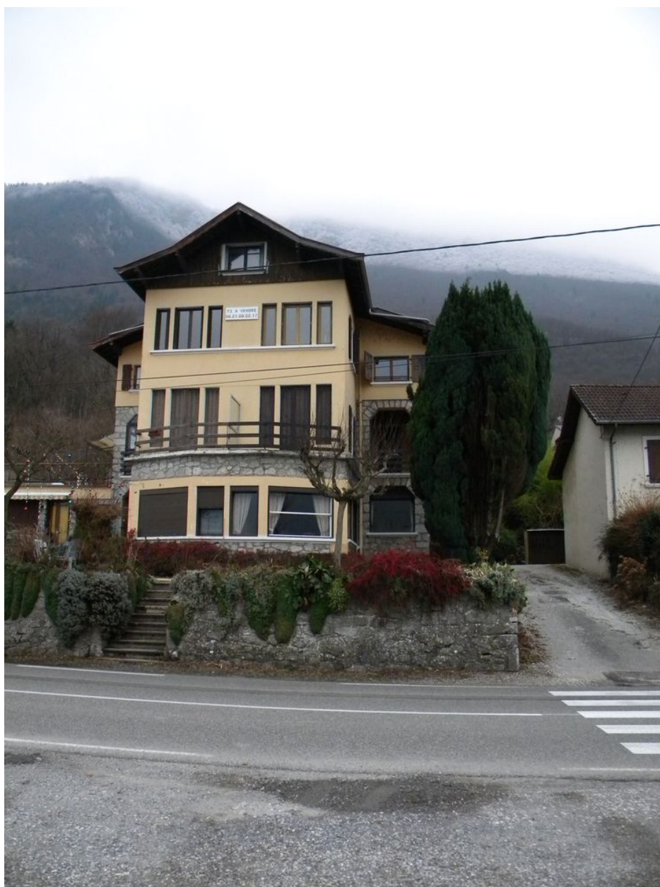
Vue de la façade principale sur le lac.
