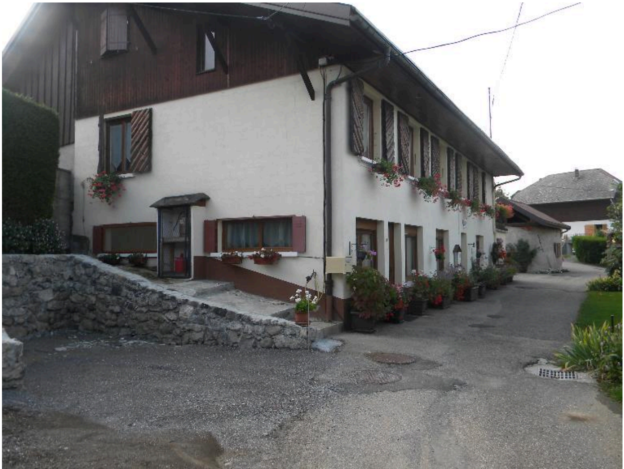
Vue d'une ancienne ferme modifiée (2008 E8 1047).
