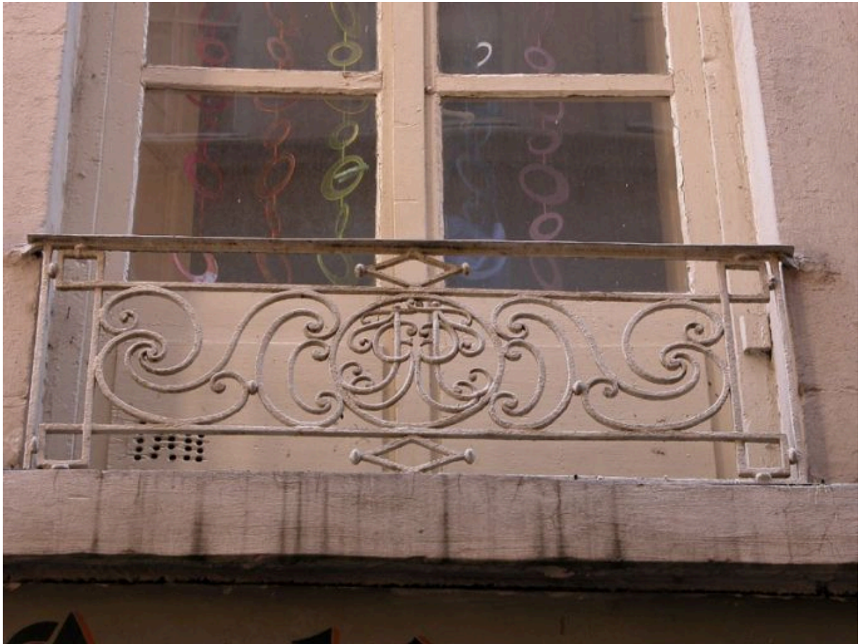
Façade principale rue du Major-Martin, 2e niveau, détail du garde-corps de la 2e fenêtre
