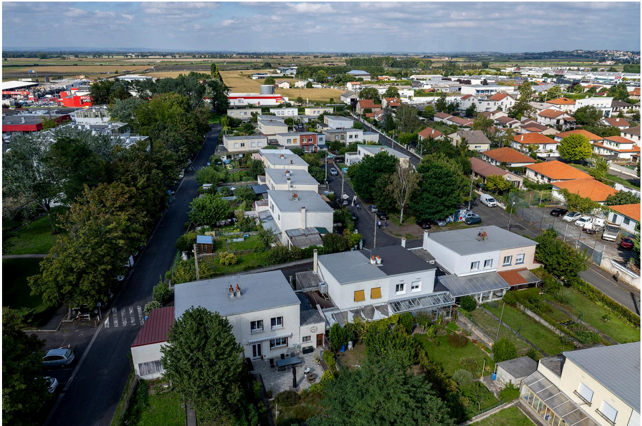
Vue aérienne, depuis le sud, de l'extension de la cité construite en mode "Castor".
