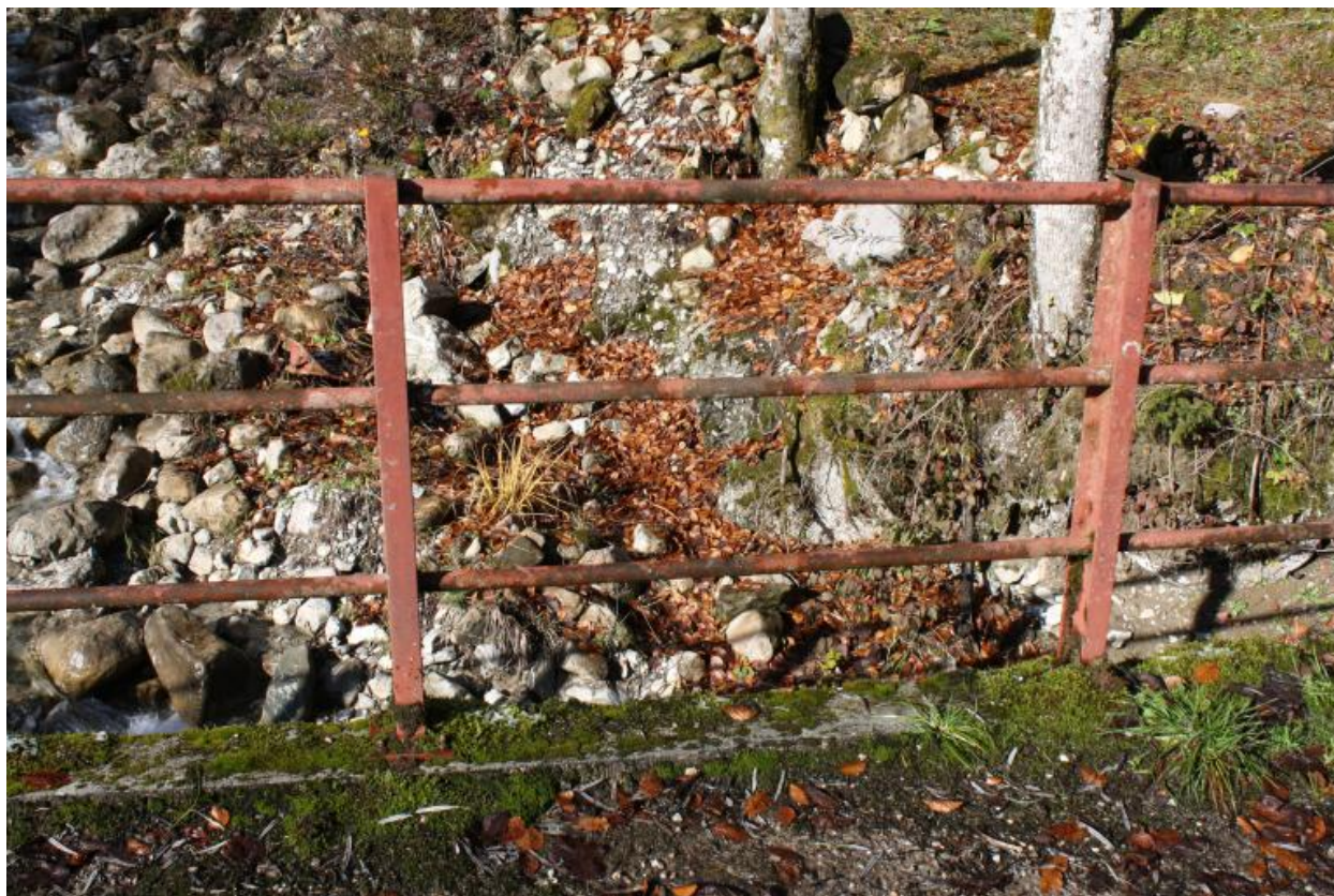
Pont des Meuniers, détail garde corps
