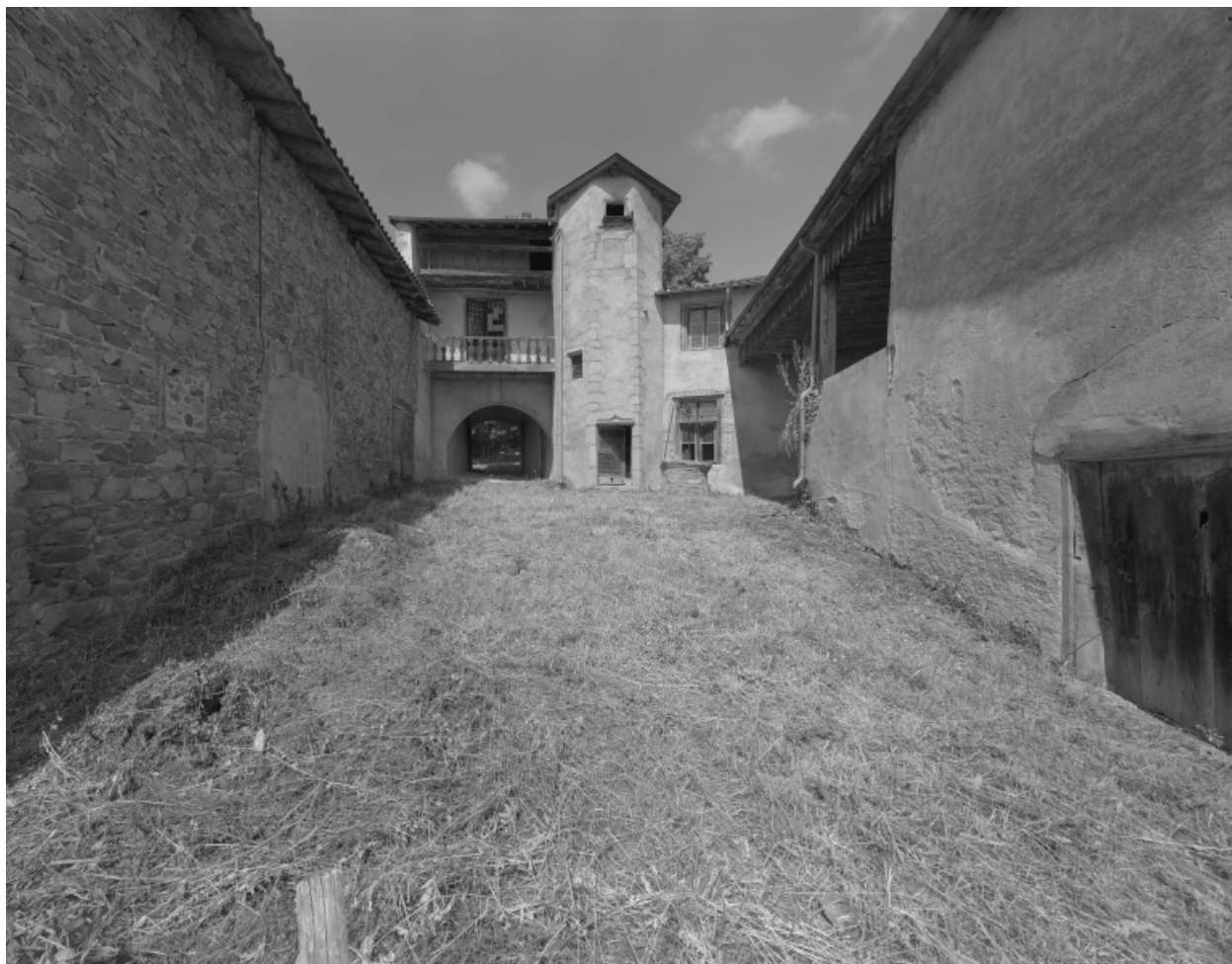
Vue d'ensemble de la cour depuis l'est.
