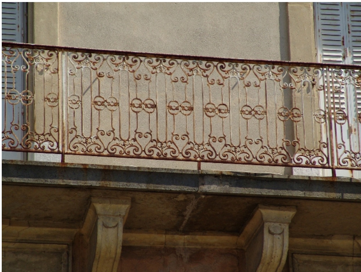
Détail d'un balcon du 2e étage
