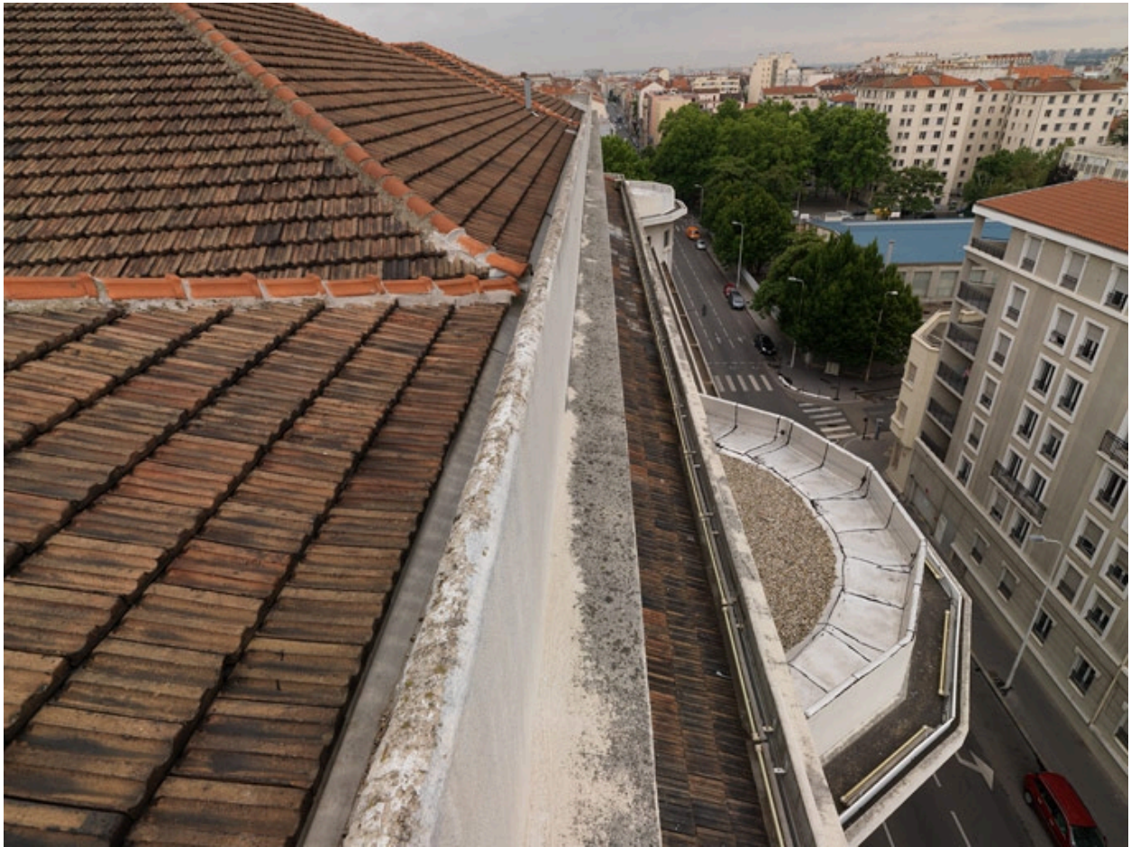
Toit vue sud-est
