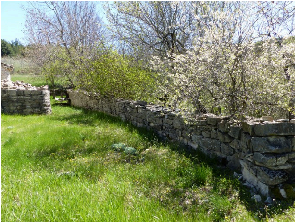
Mur de clôture entre la cour et le jardin, vue prise du nord-est.
