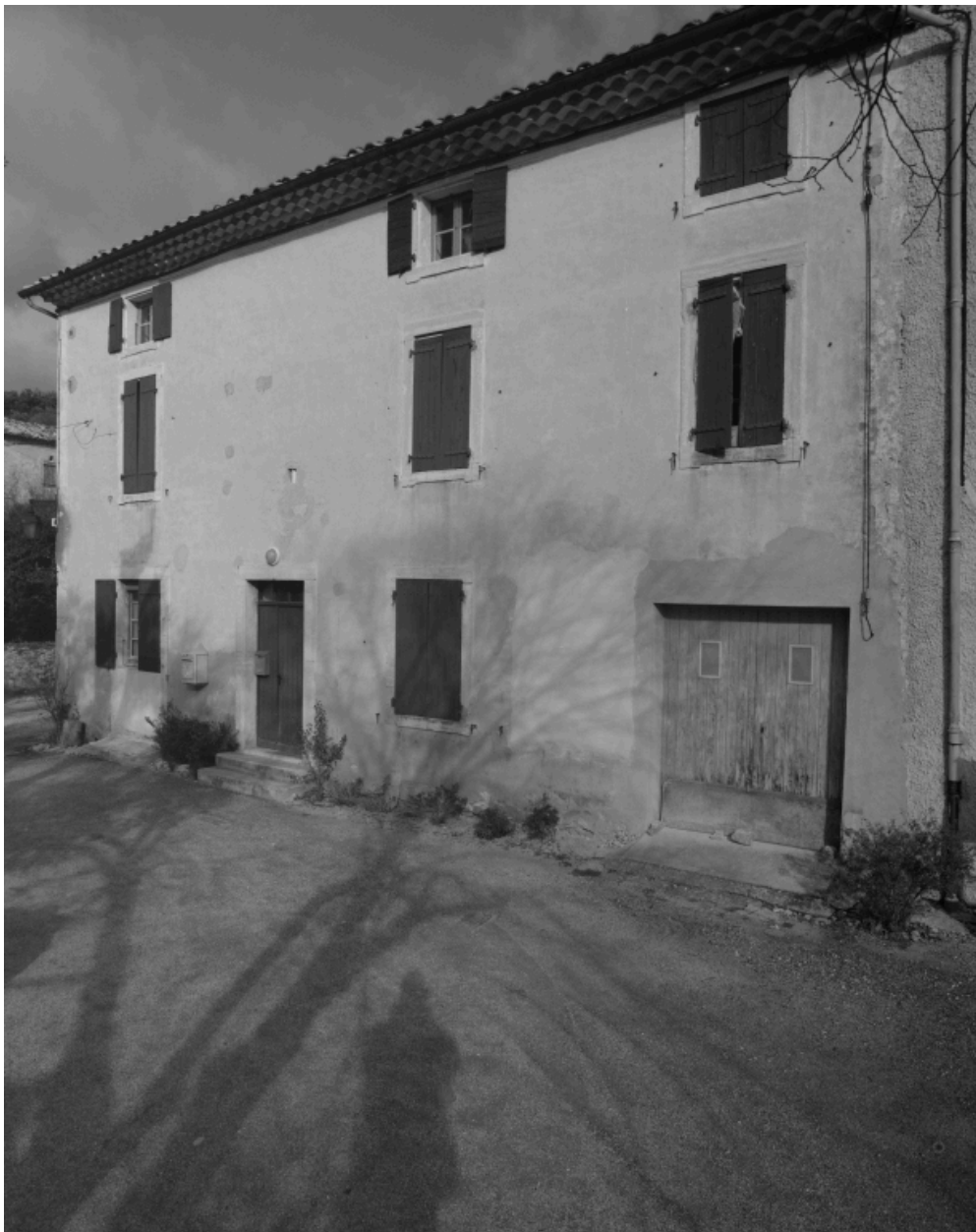
Les Clots (A1 299). Élévation principale de la maison accolée à l'église.
