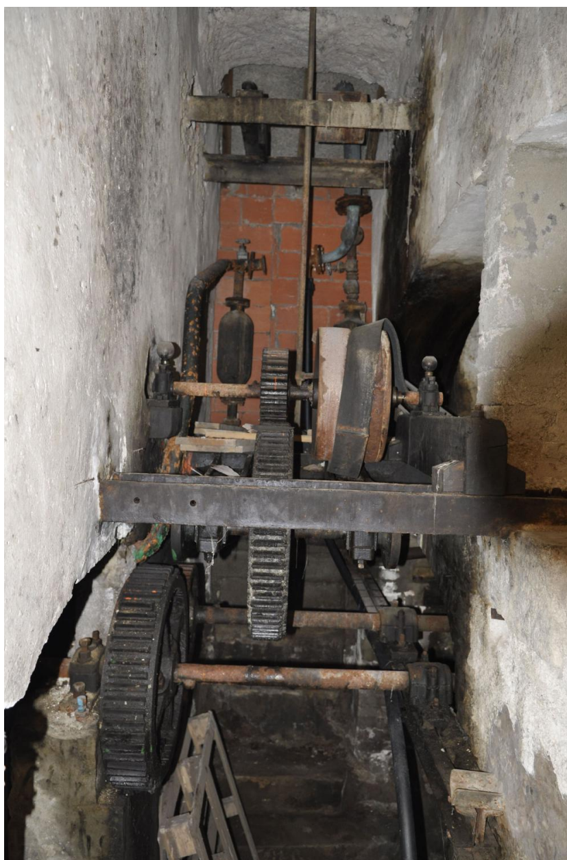
Ancien système hydraulique (vue d'intérieur)
