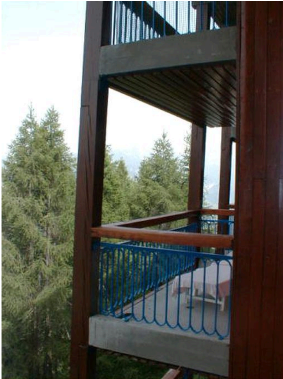
Façade ouest (aval) : détail des terrasses
