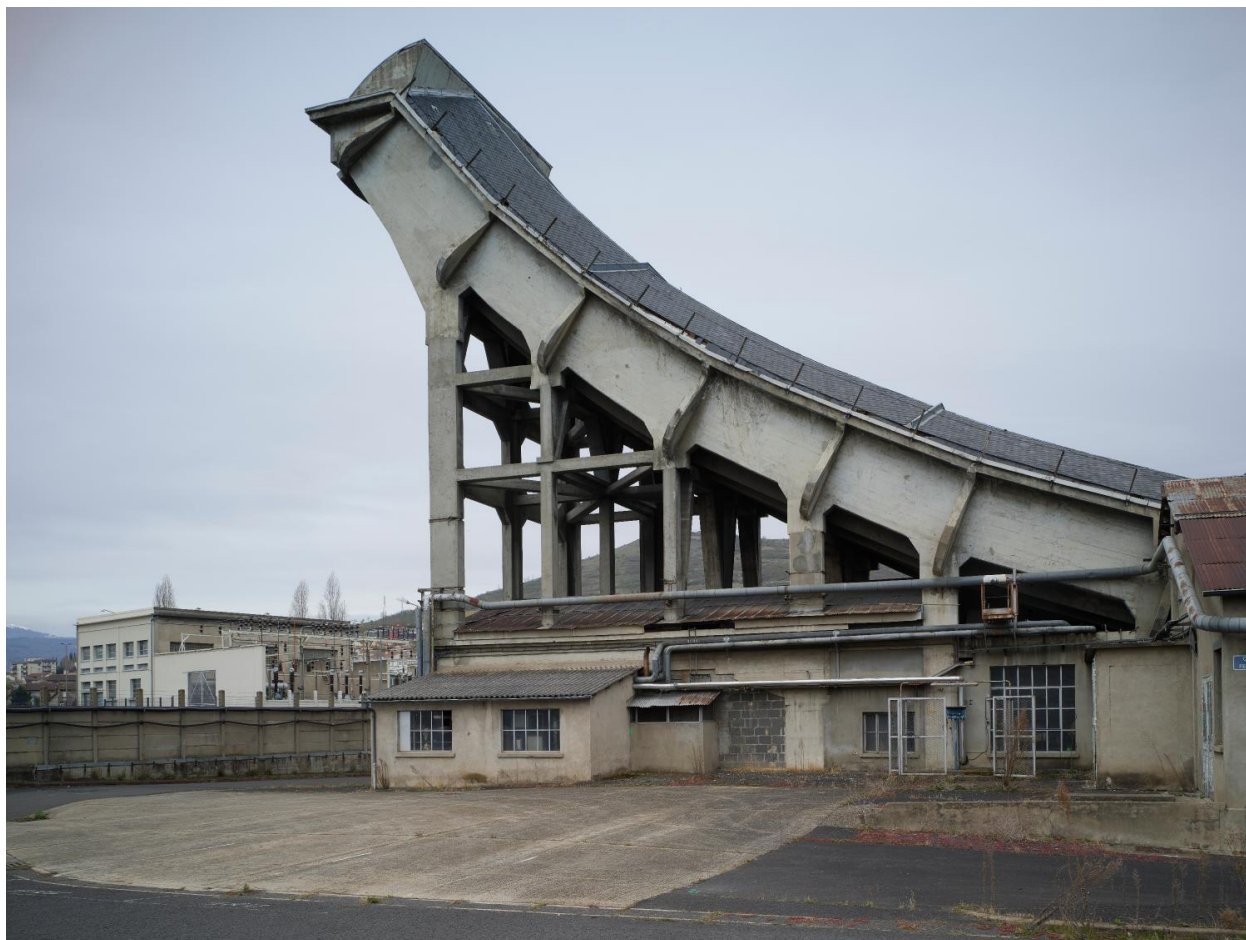
L'extrémité ouest de l'une des pistes d'essais (bâtiments F5), depuis la cour de Fernoël.
