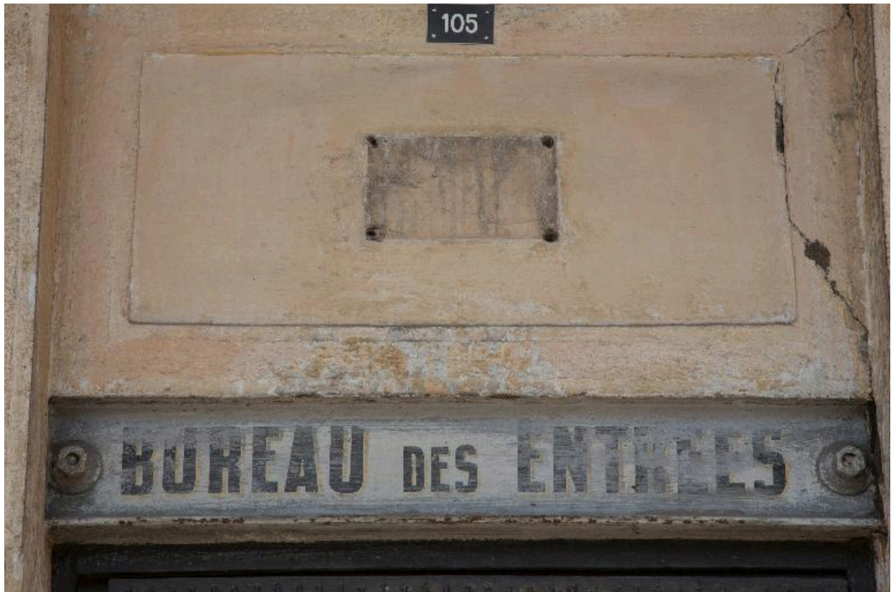
Bâtiment A. Imposte des salles : bureau des entrées
