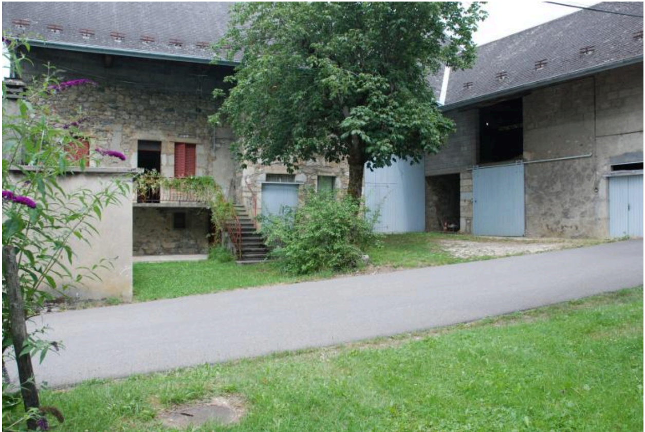
Vue d'ensemble de la ferme 2017 A1 34, 35 (non repérée), depuis le sud-ouest.
