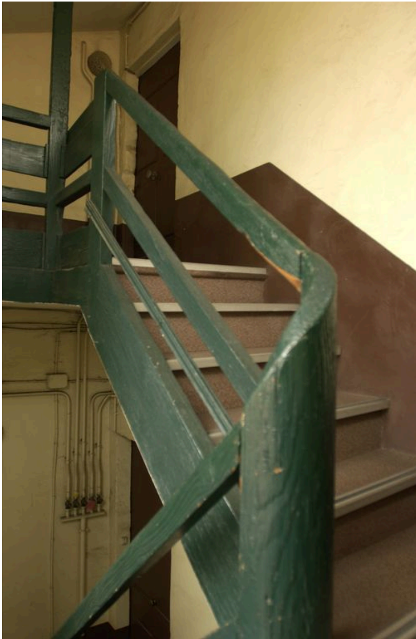
La dernière volée de l'escalier
