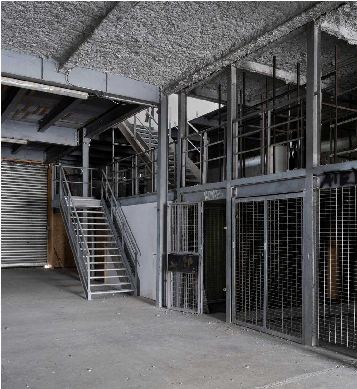
Vue intérieure niveau rez-de-chaussée
