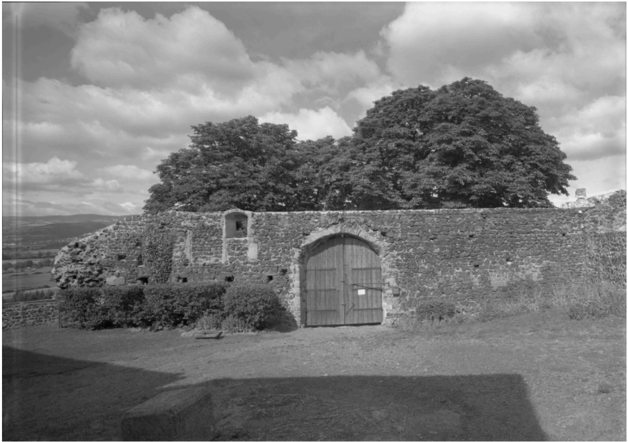
Mur ouest et portail, face interne.
