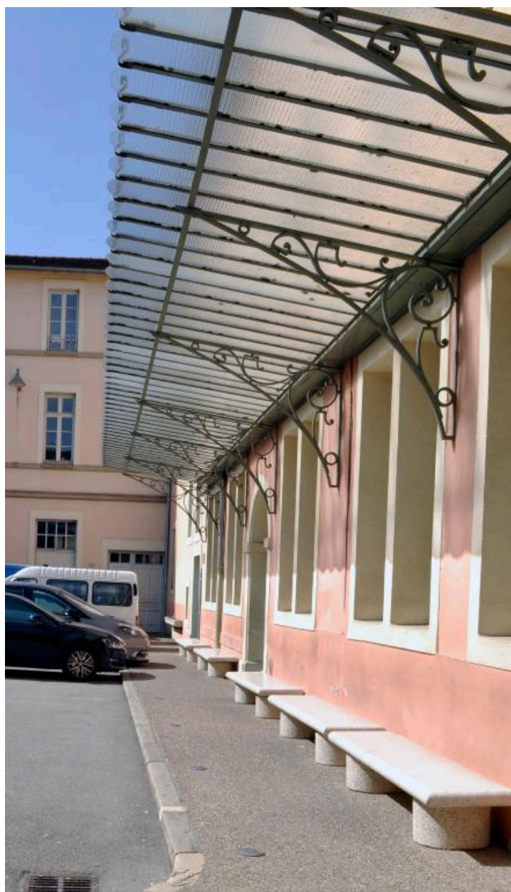
Bâtiment C : détail de la marquise sur cour 2
